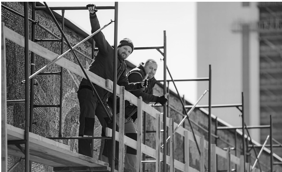
■ На уже подготовленную поверхность реставраторы начали монтировать восстановленные в мастерских крупные фрагменты мозаики
