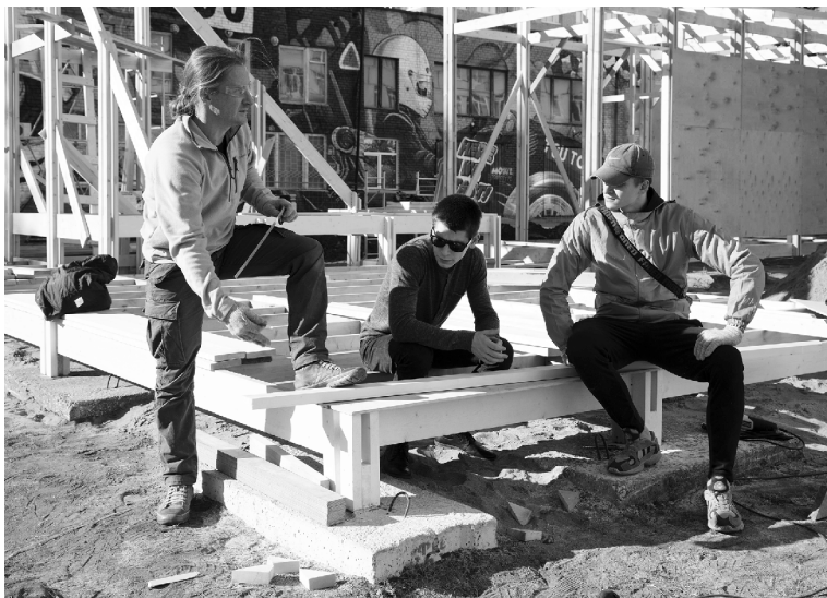
Возведение «Стрелки» — нового городского пространства для общения и отдыха, расположенного на территории кампуса ТГУ
